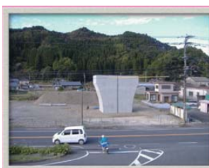
高速道路橋脚工事 (間隙充填材：佐伯市上岡) 東九州道(佐伯～蒲江間)
