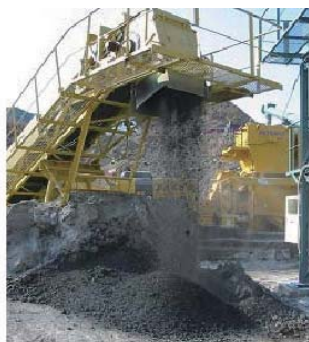
再生クラッシャーランRRC-40の製造状況
