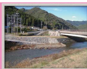
護岸工事 (裏込材料：佐伯市青山) 河川改良工事
