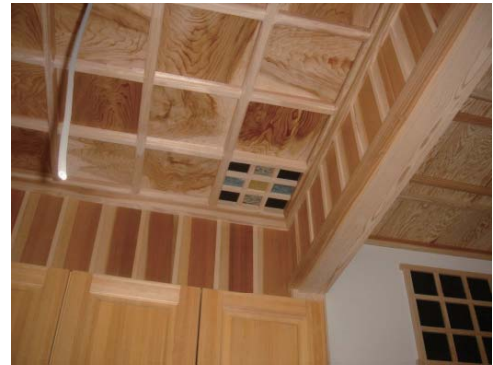
天井への施工例
