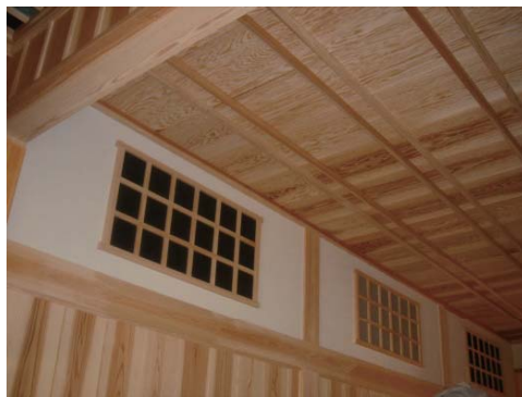
欄間への施工例
