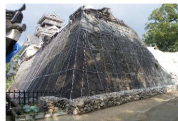
熊本城地震復旧工事
